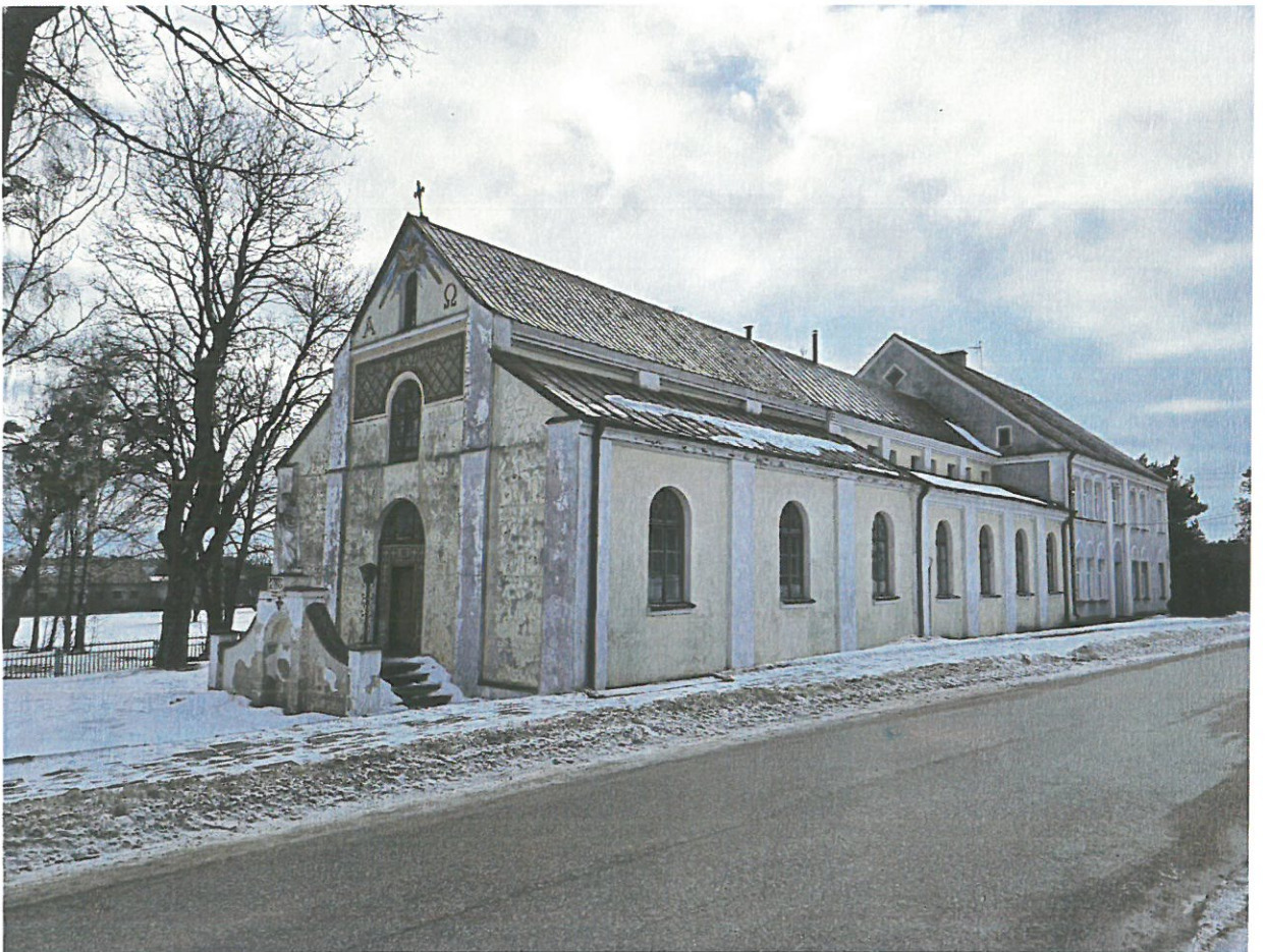
Kaplica elewacja północna.
